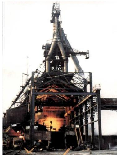
En la **cuba** se produce el primer calentamiento. En esta zona se *elimina la humedad* del mineral y se *calcina la caliza*, con desprendimiento de dióxido de carbono y formación de cal. El monóxido de carbono producido por la combustión del cok en la parte inferior se encarga de *reducir los óxidos de hierro* hasta obtener una masa esponjosa de hierro metálico.
