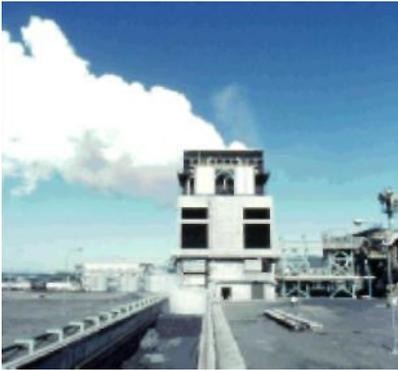
Cuando termina el proceso se extrae el carbón de cok siderúrgico de las baterías y se rocía con agua para evitar su combustión, ya que arde espontáneamente al entrar en contacto con el oxígeno del aire.
